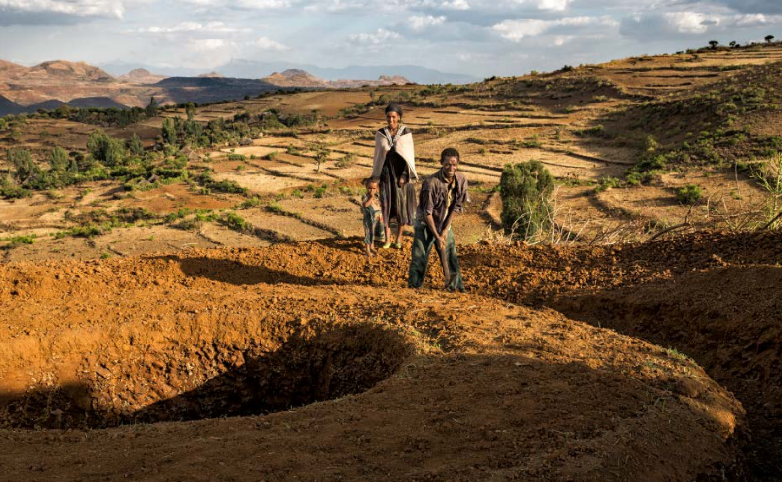
Bosie und ihr Mann Emwodeh beim Bau der Anlage, die Pflanzen in der Trockenzeit mit Wasser versorgen und Bosie ein Einkommen ermöglichen wird.
